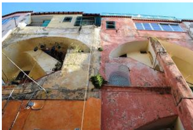
tav.9 - Casale Vascello, scale, balconi, finestre
