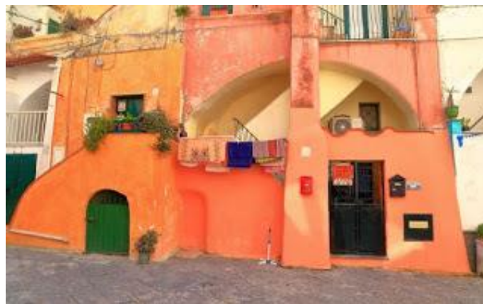
tav.8 - Area di Casale Vascello con le tradizionali abitazioni
