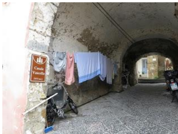
tav.6 - Ingresso al Casale Vascello
