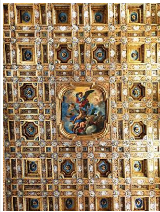
fig. 5 - Soffitto a cassettoni in legno ed oro
