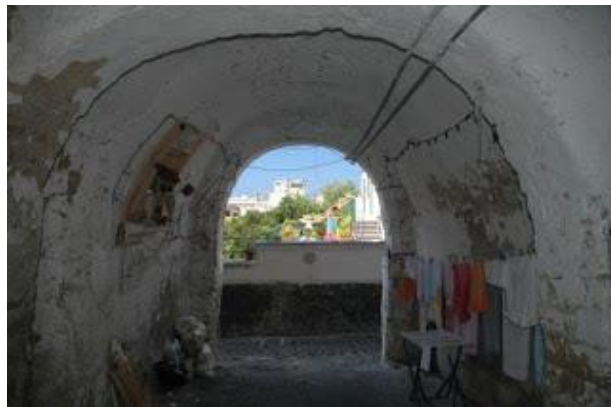
tav.5 - Ingresso al Casale Vascello
